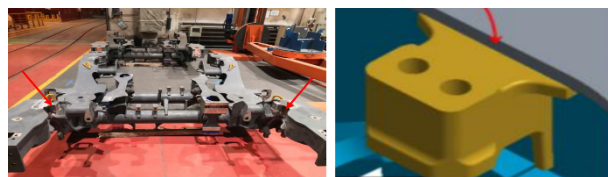
图3 转向架闸片托吊座焊缝位置
